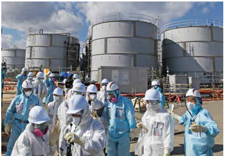
Gefährliche Arbeit: Nur in Schutzanzügen kann man sich dem havarierten Reaktor in Fukushima nähern.
